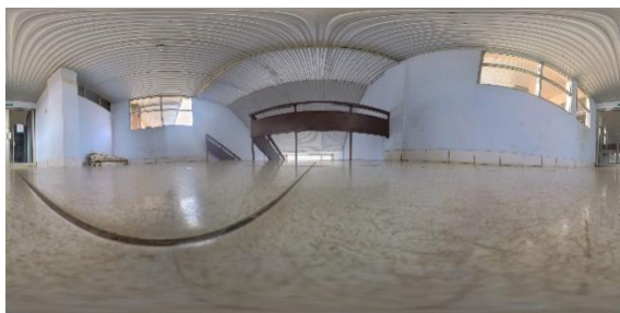
Gambar 9. Titik Empat Tampak Depan Pintu Masuk Lantai Dua
